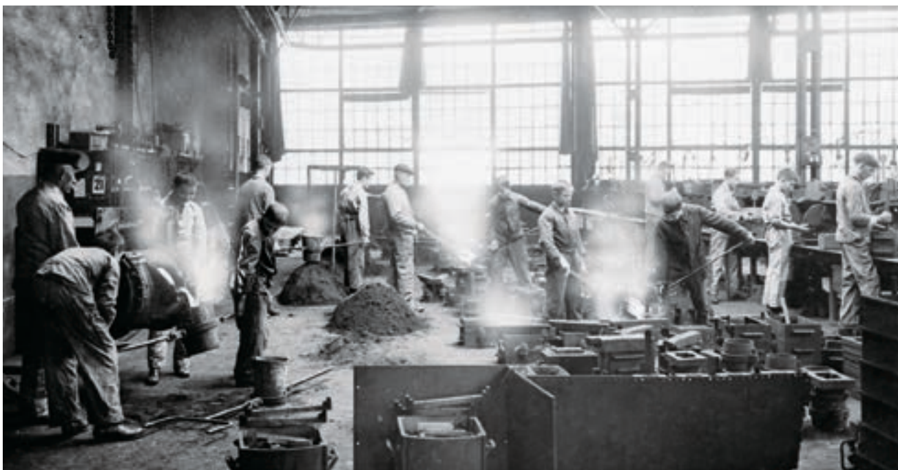
In der Lehgliesserei von Sulzer. (Bild: Archiv Sulzer AG)
